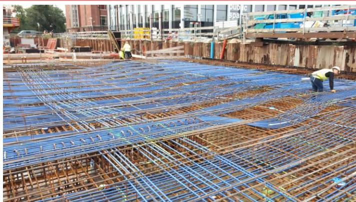
Le strutture in opera post compresse, cosiddetto sistema PT slab, sta prendendo sempre più piede anche in Italia.
