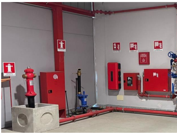
Idranti, vari tipi di idranti e naspi
