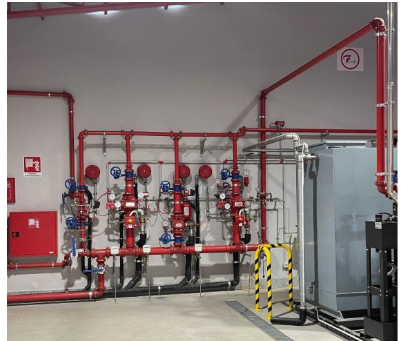
Vari tipi di gruppi di allarme per impianti sprinkler
